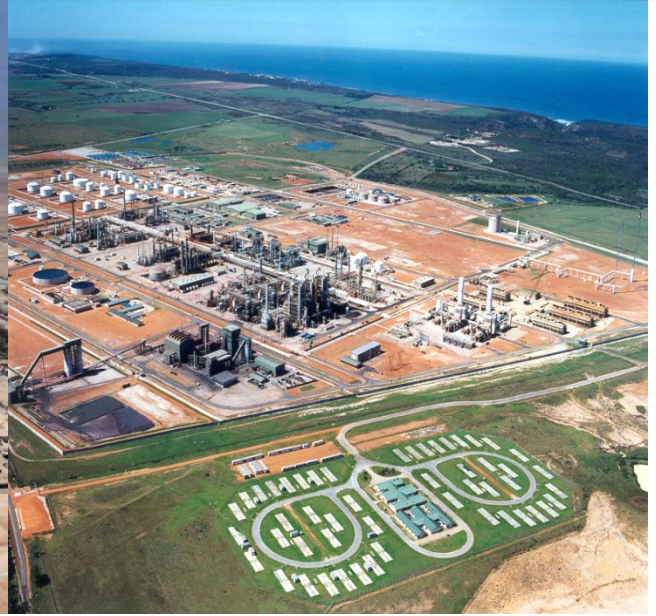
SA Mossgas 47,000 BPD Gas/Condensate to Liquids (GTL)
